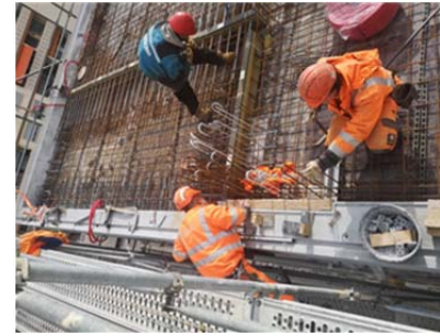
La pose des éléments préfabriqués provenant de Fribourg se fait au niveau et au millimètre.
