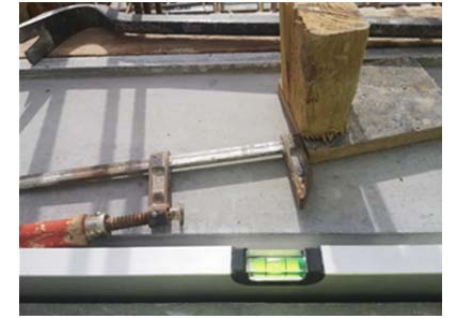
La pose des éléments préfabriqués provenant de Fribourg se fait au niveau et au millimètre.
