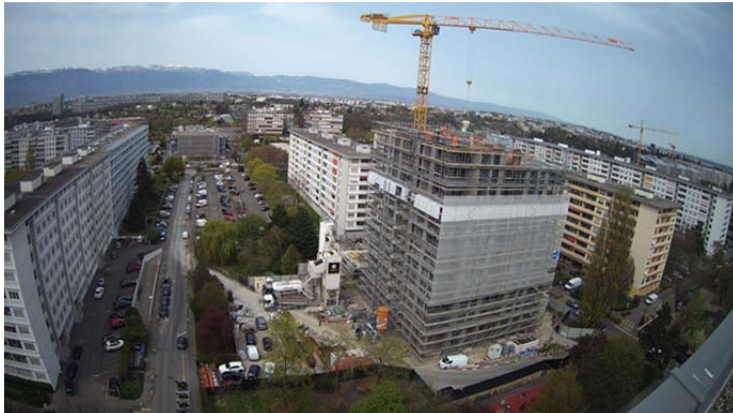
La dalle du 12ème étage est coulée, 1er étage PPE
